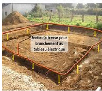
Technique de prise de terre par boucle
