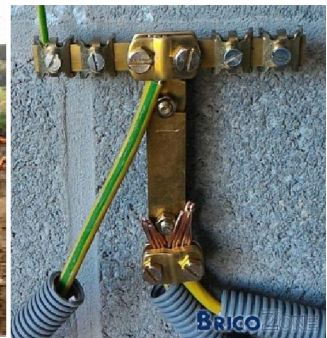
Technique de prise de terre par boucle
